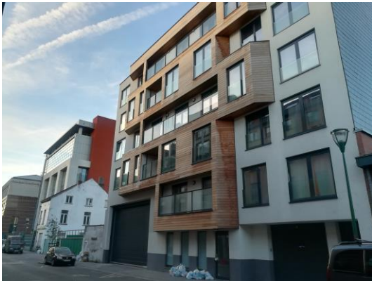
Figure 60 : Façade partiellement en saillie avec revêtement bois, rue de l'Intendant, Molenbeek-Saint-Jean (ABO)
